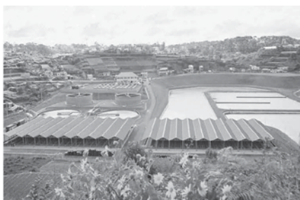
Usine de traitement des eaux usées de Đà Lạt
